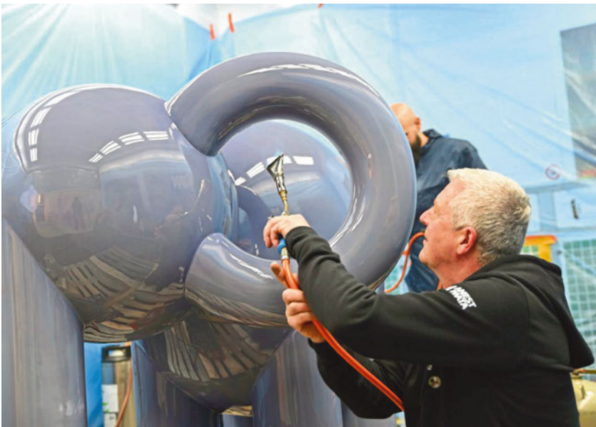
Da man die Fläche nicht schleifen kann, sorgt das Beflammen dafür, dass die Beschichtung haftet.
